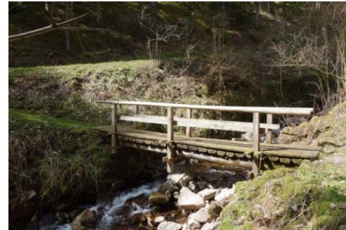
Bei der Fohrenbachmühle am Segaler Bach
